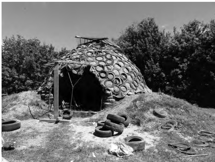
Fig. 1 – Eco Centro Ecológico nella scuola di Jardinería y Paisajismo EMAJEA; la struttura è composta da una base di forma circolare costituita da pneumatici riciclati riempiti di cemento, calce e sabbia
